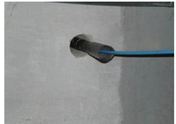
Mit einer Mauerdurchführung wird dann das Glasfaserkabel in Ihren Hauswirtschaftsraum oder Keller gelegt (wie der bisherige Telefonanschluss). Nach dem Anschluss wird die Wand wieder luft- und wasserdicht verschlossen.
